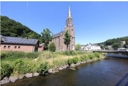
Nach der Flut umfangreich saniert: Die Kirche St. Nikolaus in Gemünd.
