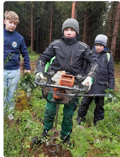
In Vossenack wird schweres Gerät eingesetzt.
